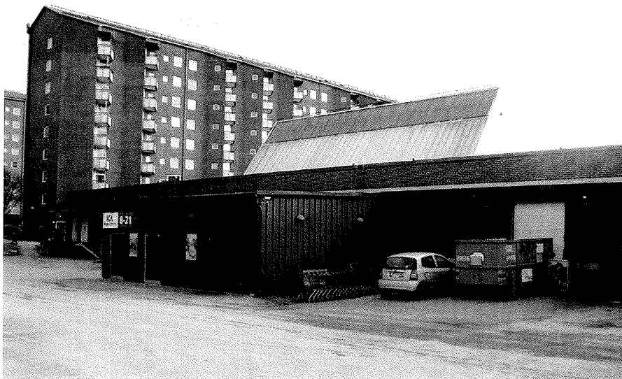
Befintligt miljöhus / lastkaj.
